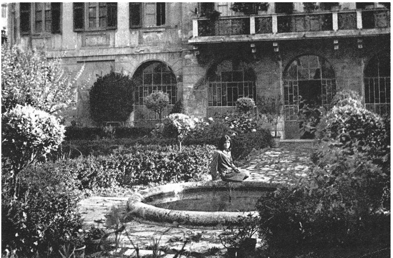
Foto 27 (Progetto Manutenzione straordinaria del Palazzo Simoni Fe – Arch. Martino Cere) – Il cortile del Palazzo Simoni Fè 1950
