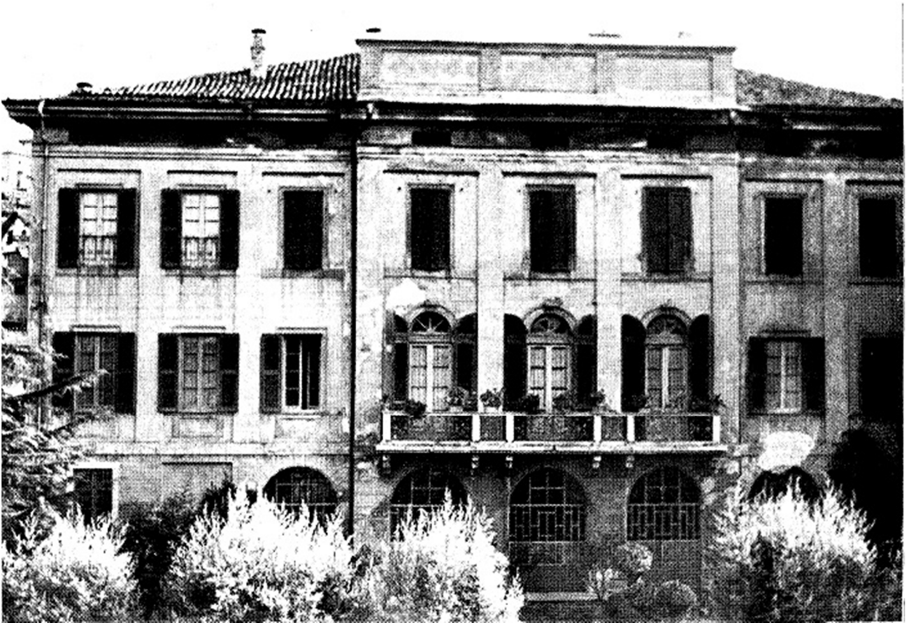
Foto 26 (Progetto Manutenzione straordinaria del Palazzo Simoni Fe – Arch. Martino Cere) – Il cortile del Palazzo Simoni Fè 1950
